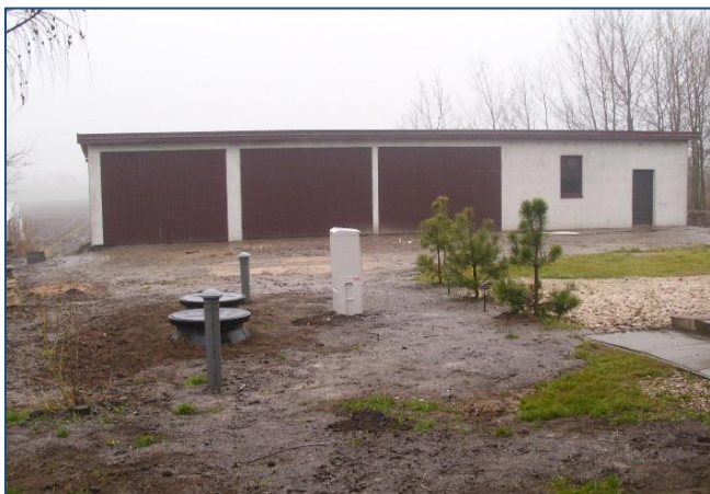
Przydomowe oczyszczalnie ścieków (99+5)
