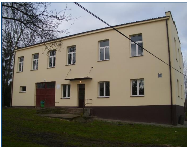
Budynek remizo – świetlicy w Czarnocinie
