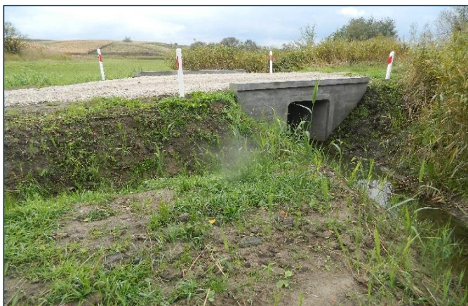
Wybudowany nowy przepust w Korycie.
