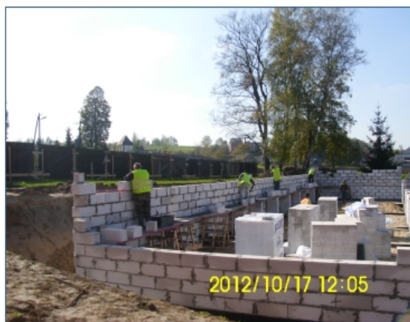
Plac budowy w Czarnocinie
