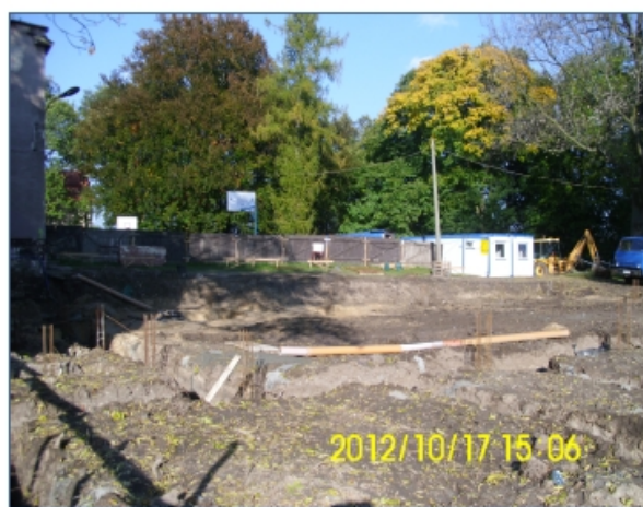
Plac budowy w Cieszkowach
