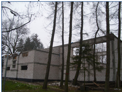
Plac budowy w Cieszkowach
