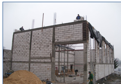
Plac budowy w Czarnocinie
